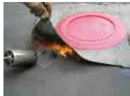
3. A bitumengallért a már lefektetett bitumenlemezhez hegesztjük
