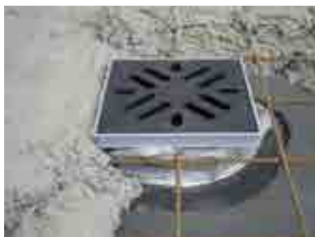
8. Betonnal feltöltjük a végleges szintig
